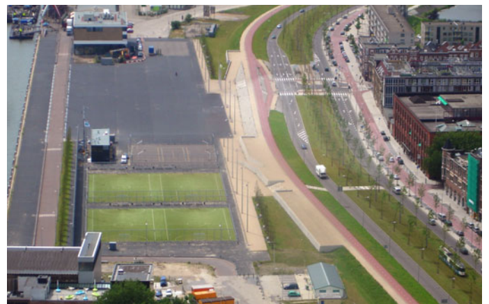
luchtfoto in de laatste fase van de aanleg
