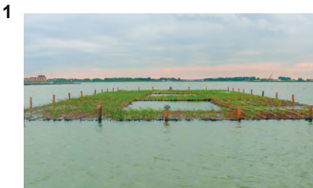
1 Drijvend rieteiland (RWS Waterproeftuin 2009) 2 Rijswerk van wilgentenen, basis rieteiland
